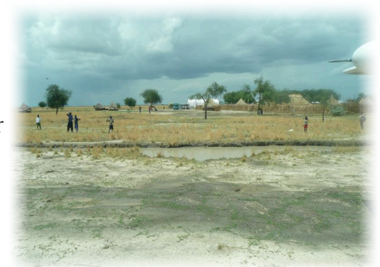
Drainage-Gräben nehmen viel Pisten-Wasser auf
